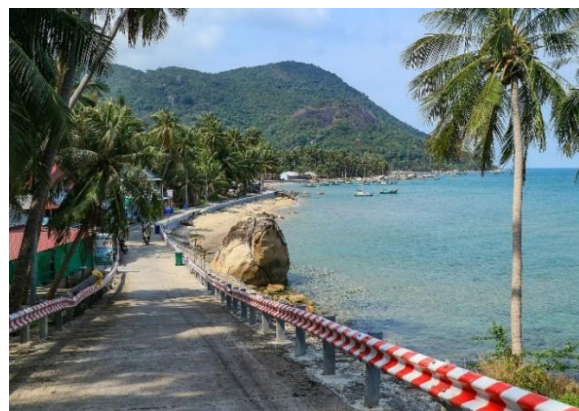
Hình 50. Đường quanh xã đảo Lai Sơn
