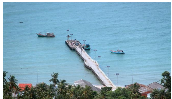
Hình 55. Cầu cảng Bãi Nhà (xã Lại Sơn)
